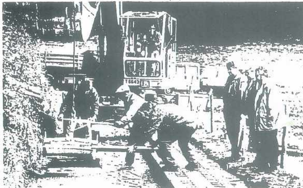
Die Elemente werden in Deutschland hergestellt und müssen vor Ort nur noch zusammengefügt werden
